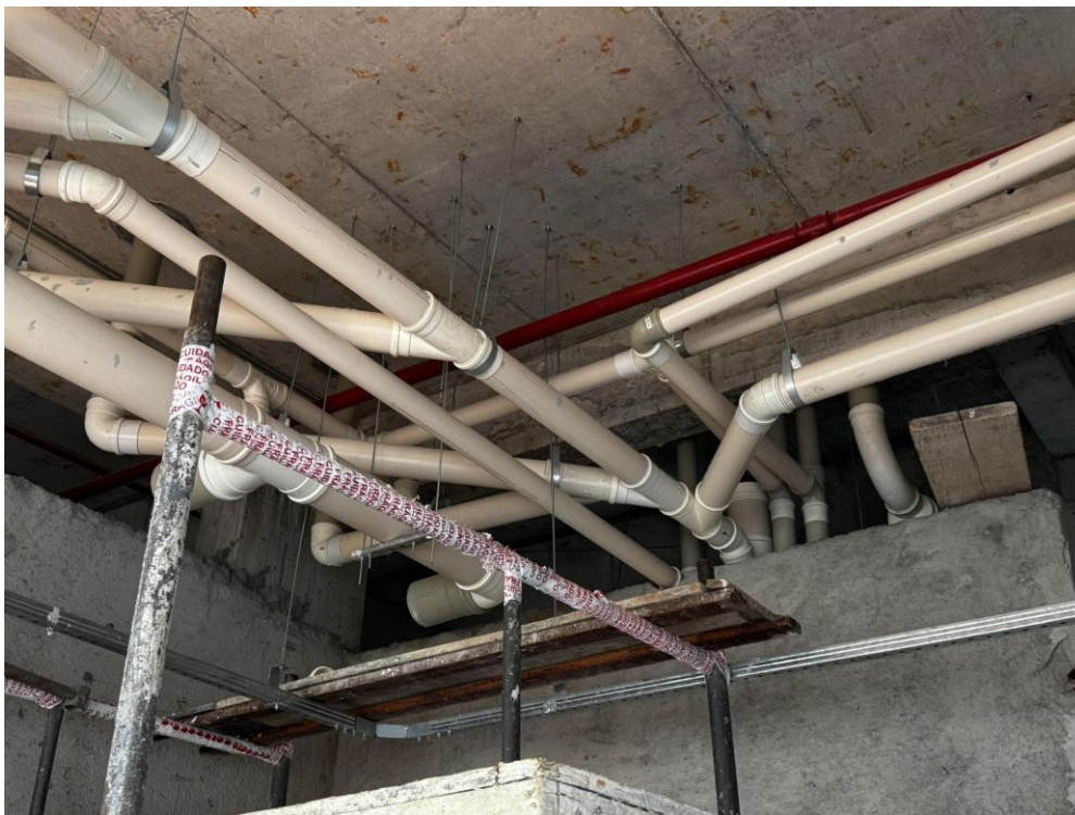
Figura 13. Execução das instalações das tubulações de esgoto.
