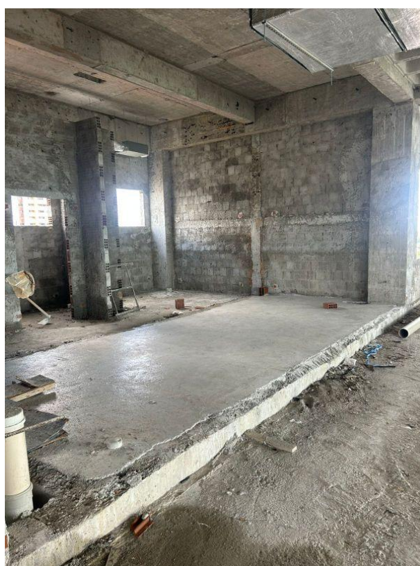
Figura 21. Sala de ar condicionado no segundo pavimento sem parede e com o piso final executado
