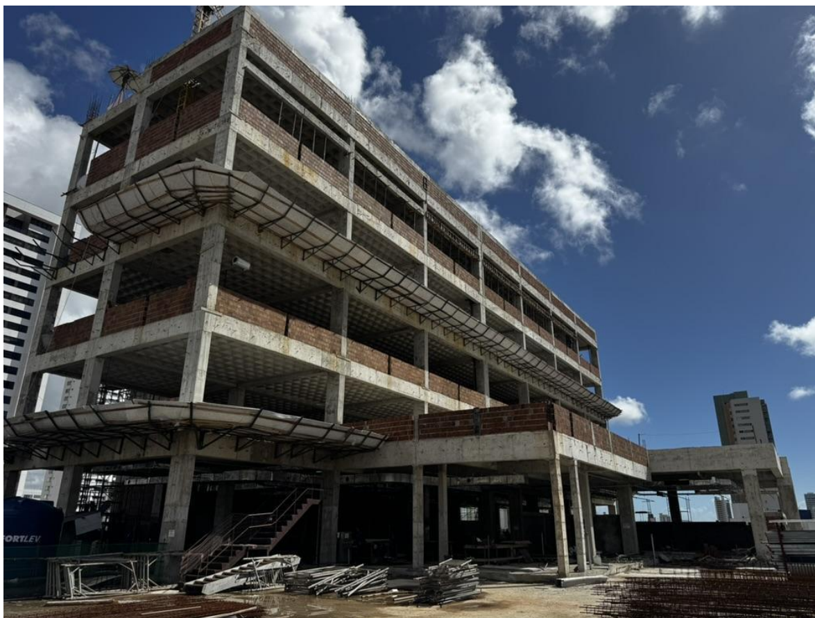
Figura 1. Visão geral da obra.
