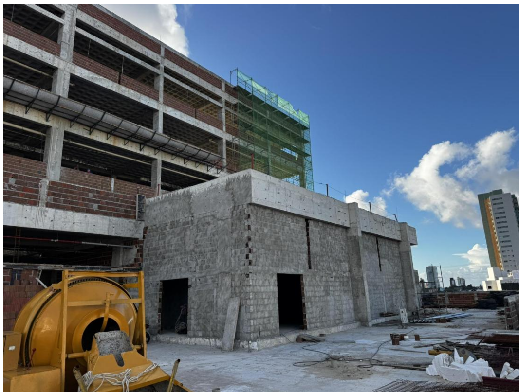
Figura 9. Execução de alvenaria com tijolos cerâmicos de 14cm de largura no perímetro dos pavimentos e auditório
