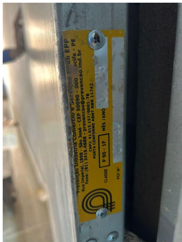
Figura 12. Execução de porta corta fogo.
