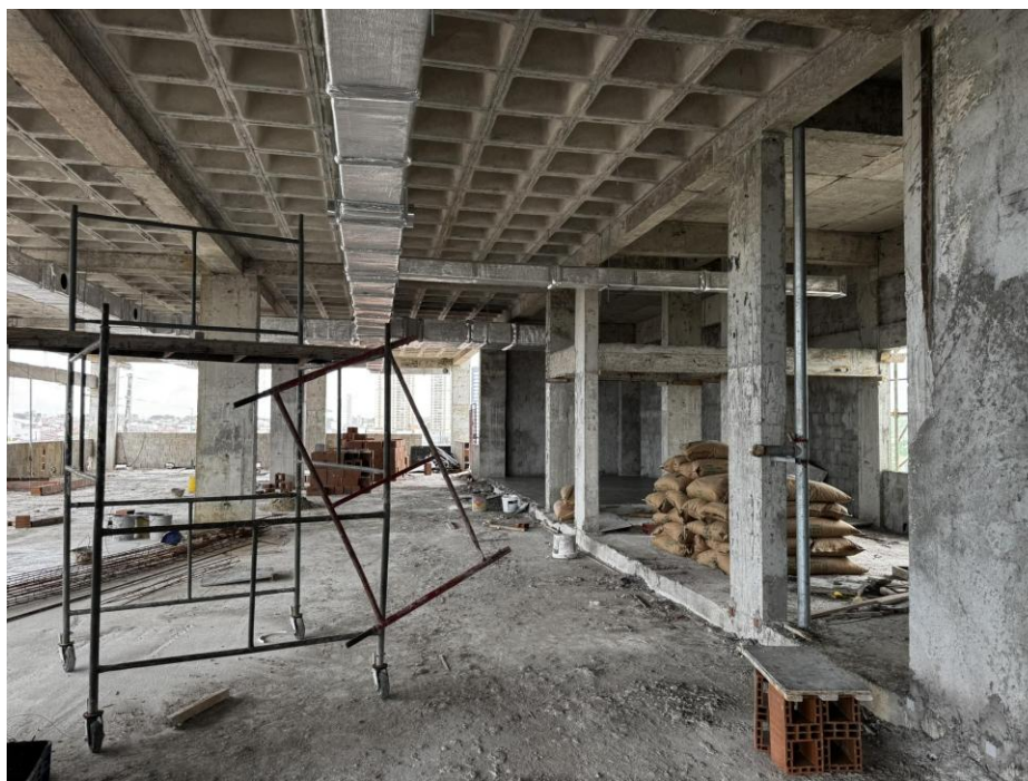
Figura 16. Instalação da tubulação dos dutos de ar-condicionado galvanizados já com o isolamento.
