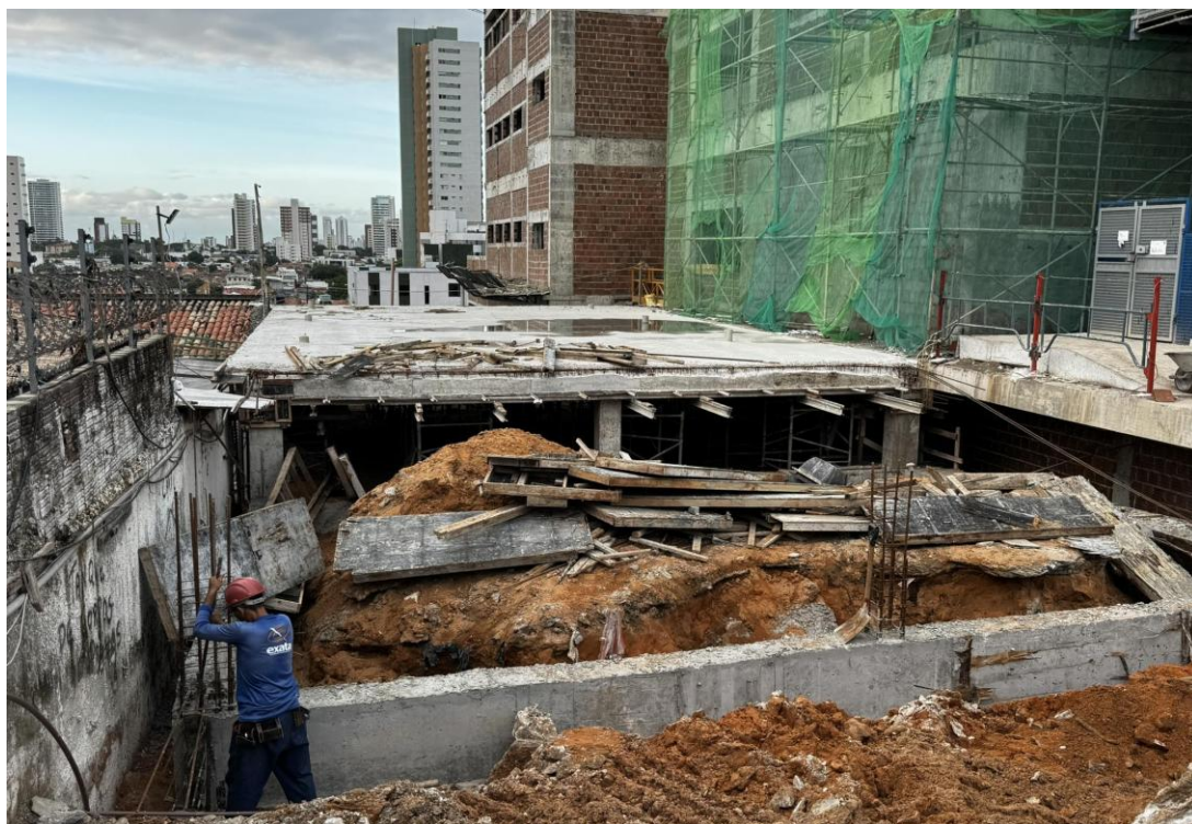
Figura 3. Concretagem das vigas de fundação, pilares e laje de cobertura do “Caixão Perdido”.
