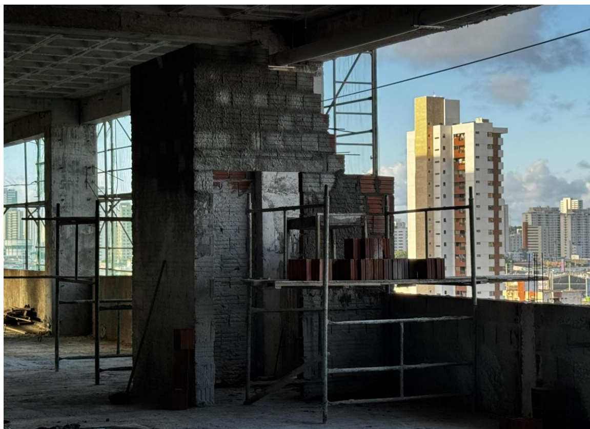
Figura 7. Execução de alvenarias com tijolos de 9cm de espessura nos banheiros do terceiro pavimento.
