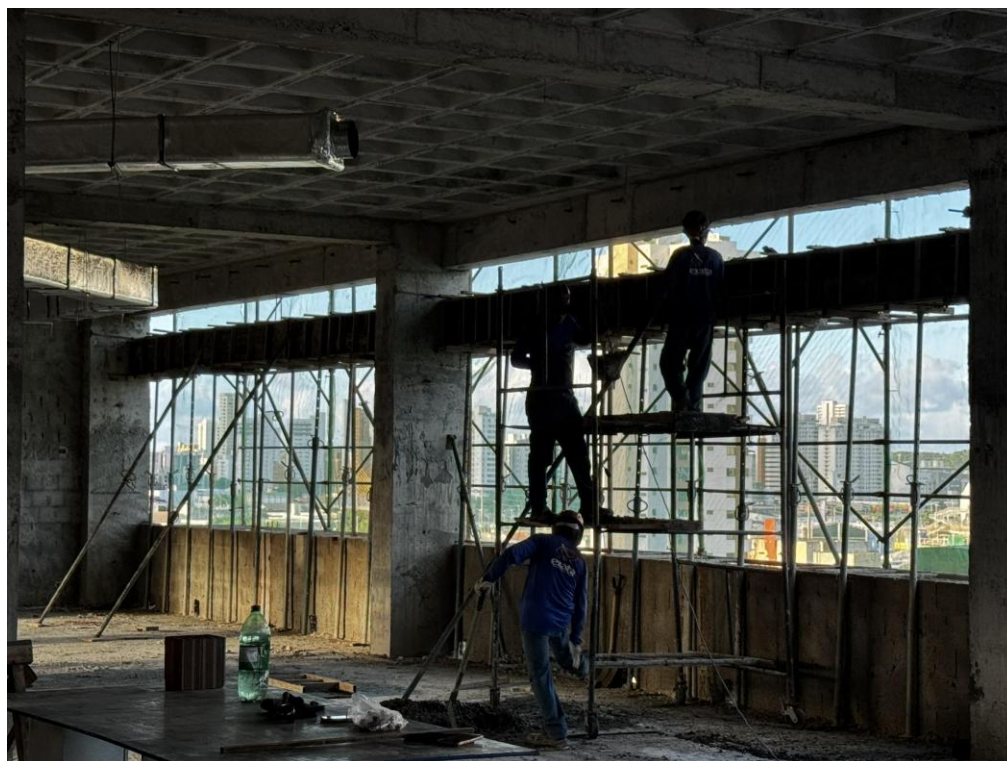
Figura 5. Vigas intermediárias nos pavimentos.
