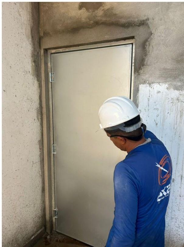
Figura 11. Execução de porta corta fogo.
