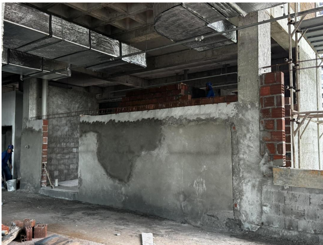
Figura 10. Execução de alvenaria com blocos cerâmicos com 19cm de espessura com aplicação de vermiculita, chapisco e reboco nas salas dos ar condicionados.
