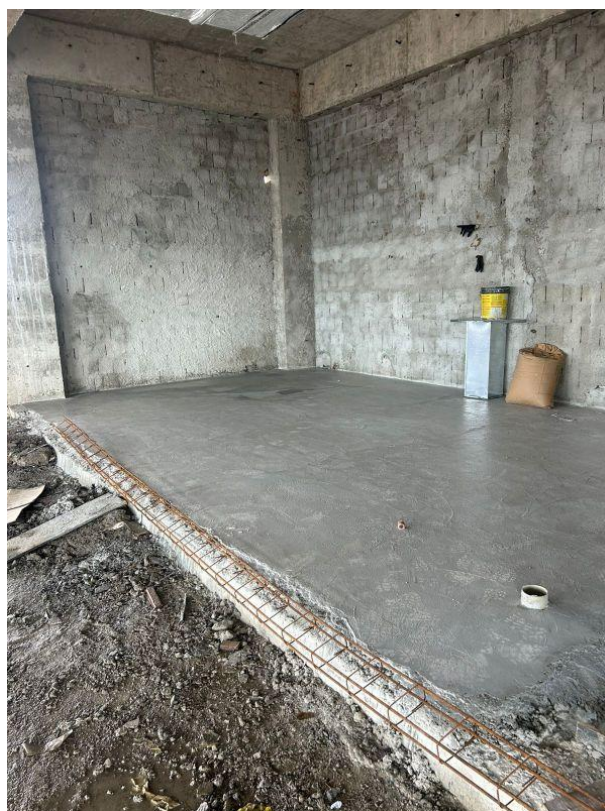
Figura 22. Sala de ar condicionado no segundo pavimento sem parede e com o piso final executado
