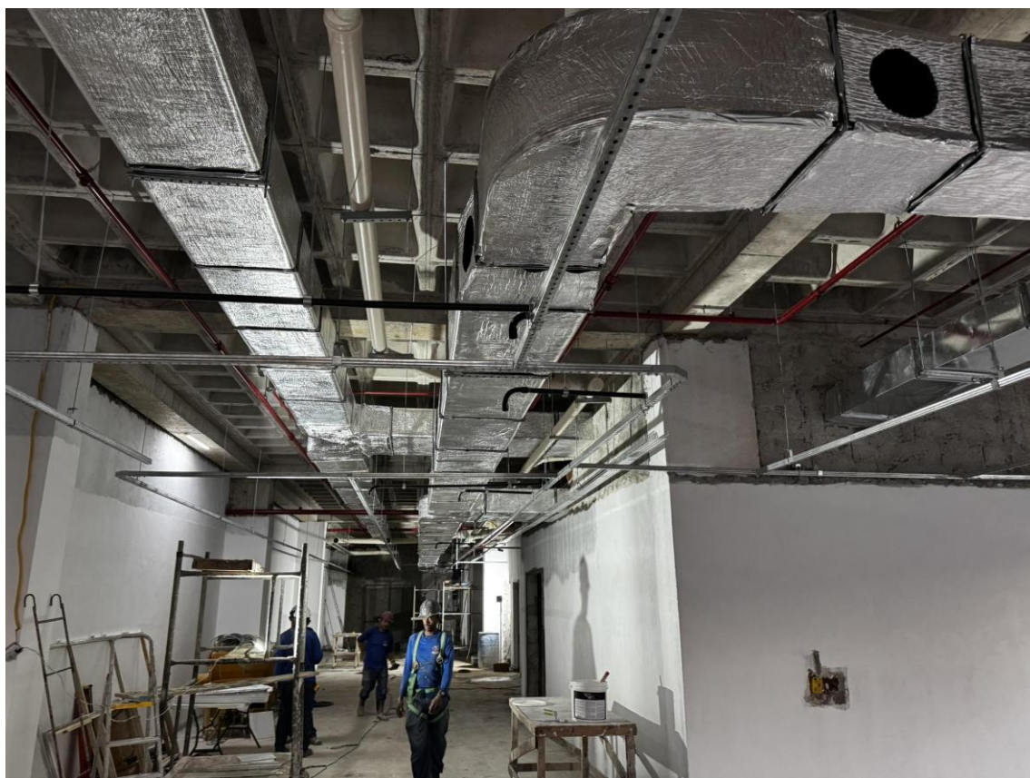
Figura 15. Instalação da tubulação dos dutos de ar-condicionado galvanizados já com o isolamento.
