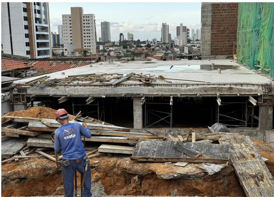
Figura 4. Laje do “Caixão perdido” após concretagem.
