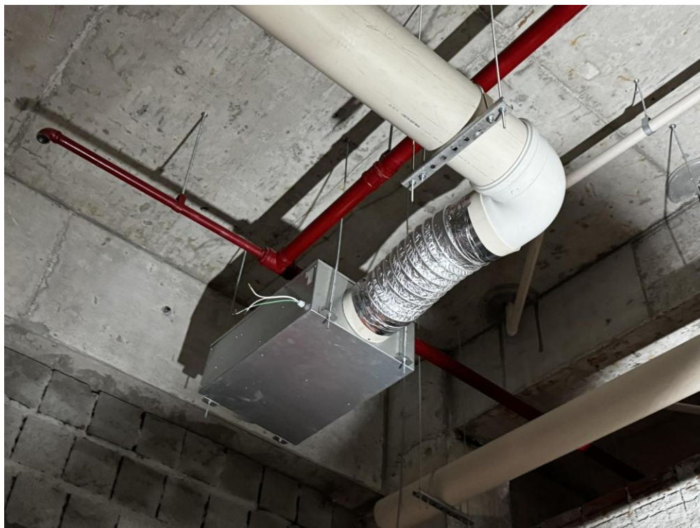
Figura 17. Instalação de Exaustor, item 15.1.2 da planilha.
