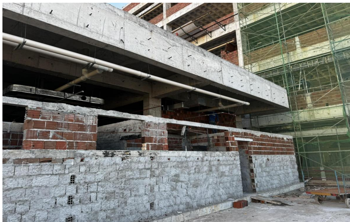
Figura 8. Execução de alvenaria 14 cm no perímetro do auditório no pavimento térreo.
